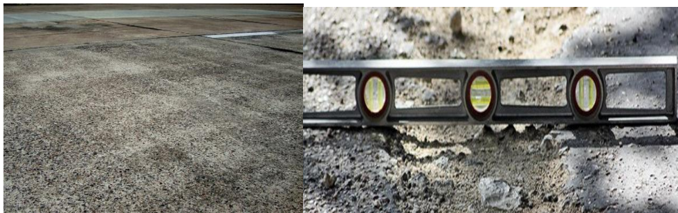
1-расм. Асфальтбетон қопламаларидаги емирилиш ҳолати.
