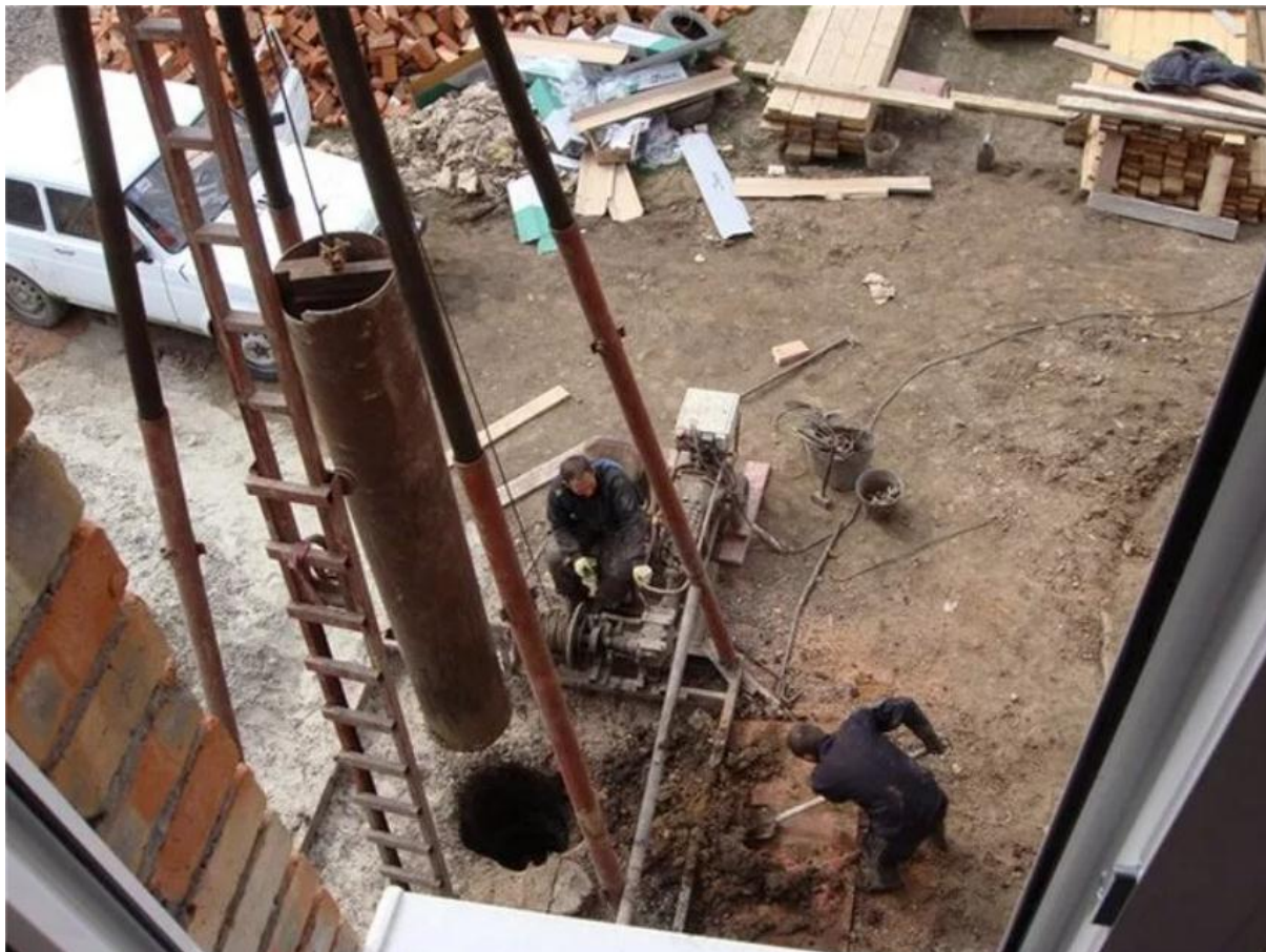
Рис 3. Ударно- канатное бурение скважин
